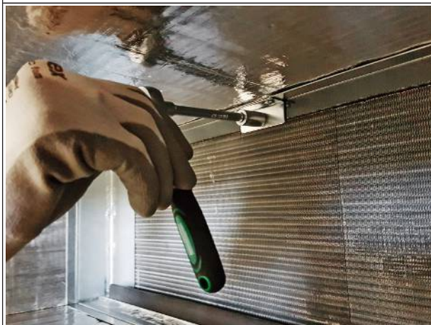
III. : 13: Serrer les vis à l'intérieur
