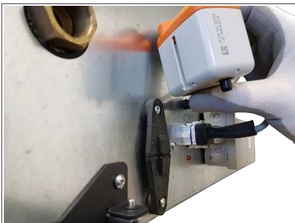
III. : 25: Pousser la pompe d'eau de condensation
