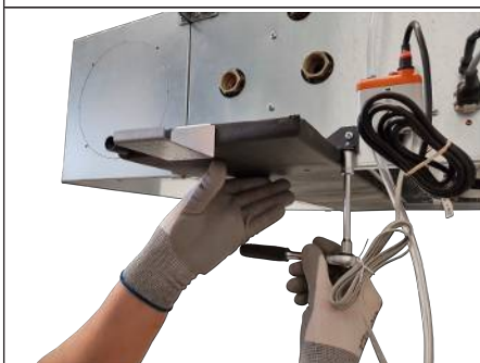
III. : 61: Desserrer et maintenir le collecteur d'eau de condensation
