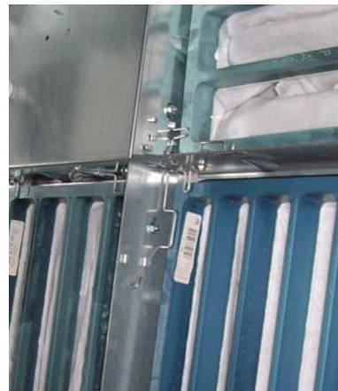
Abb. 15, 16: Filterrahmen mit Drahtspangen wieder befestigen!
