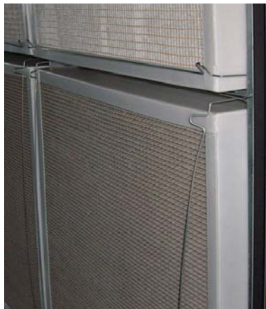
Abb. 15, 16: Filterrahmen mit Drahtspangen wieder befestigen!
