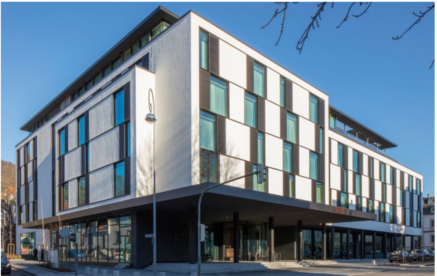
Das frisch eröffnete „Roomers“ in Baden Baden – hier wurde eine große Bandbreite von Kampmann-Produkten installiert.
